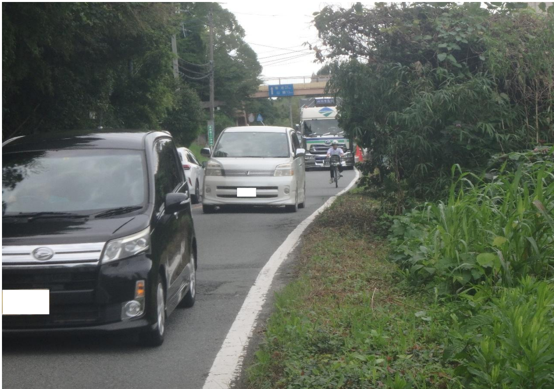
南関町相谷地内:南関町立第三小学校付近(拡幅改良・歩道整備)
