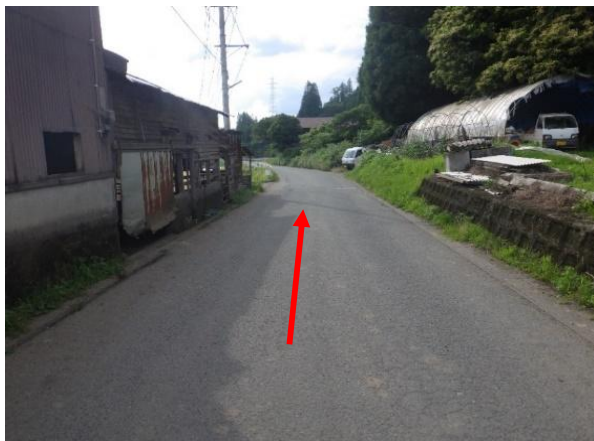
⑪未改良区間
