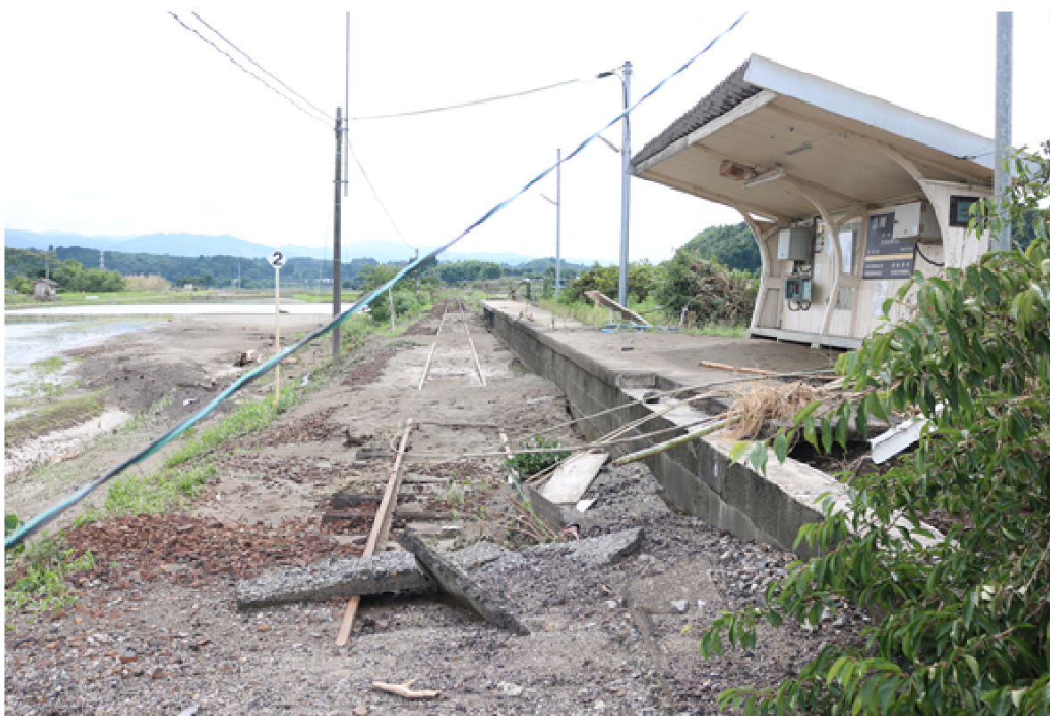
相良村川村駅 (被災状況)
