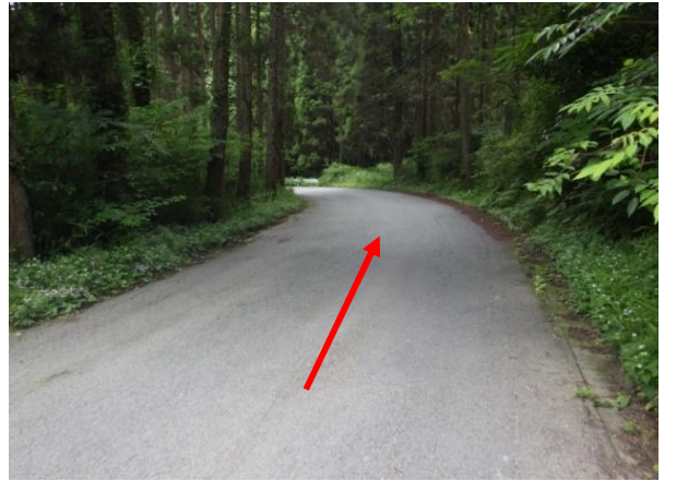
⑥未改良区間
