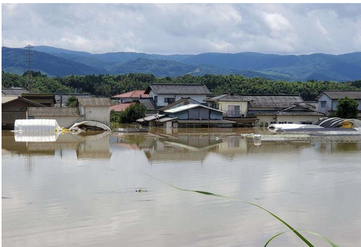
錦町一武 (浸水状況)
