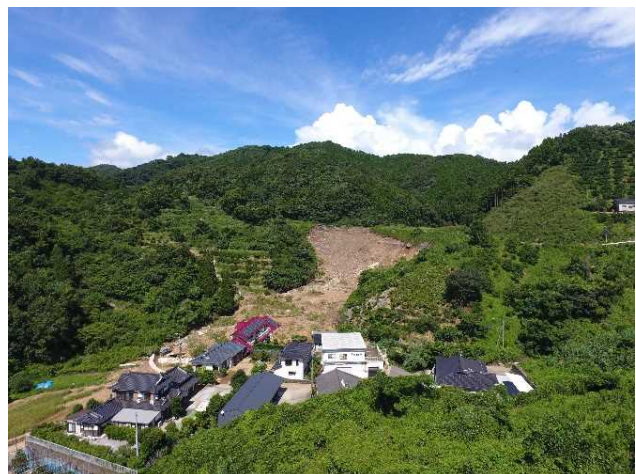
山腹崩壊 つるぎやま (芦北町・鶴木山地区)
