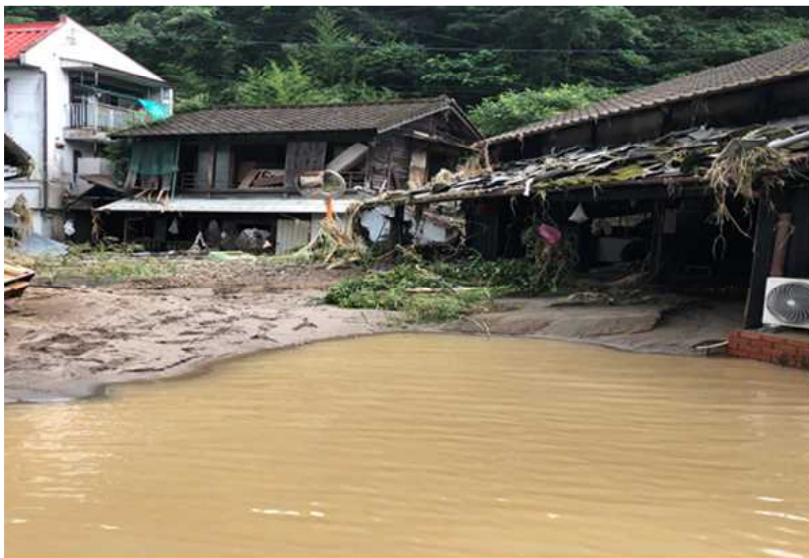
球磨村一勝地（被災状況）
