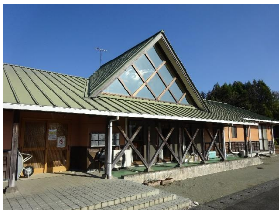
大久保高齢者住宅（外観）
