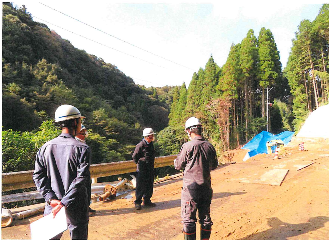
令和5年度2次補道第5680号村道岩ヶ野下弘線道路災害復旧工事
