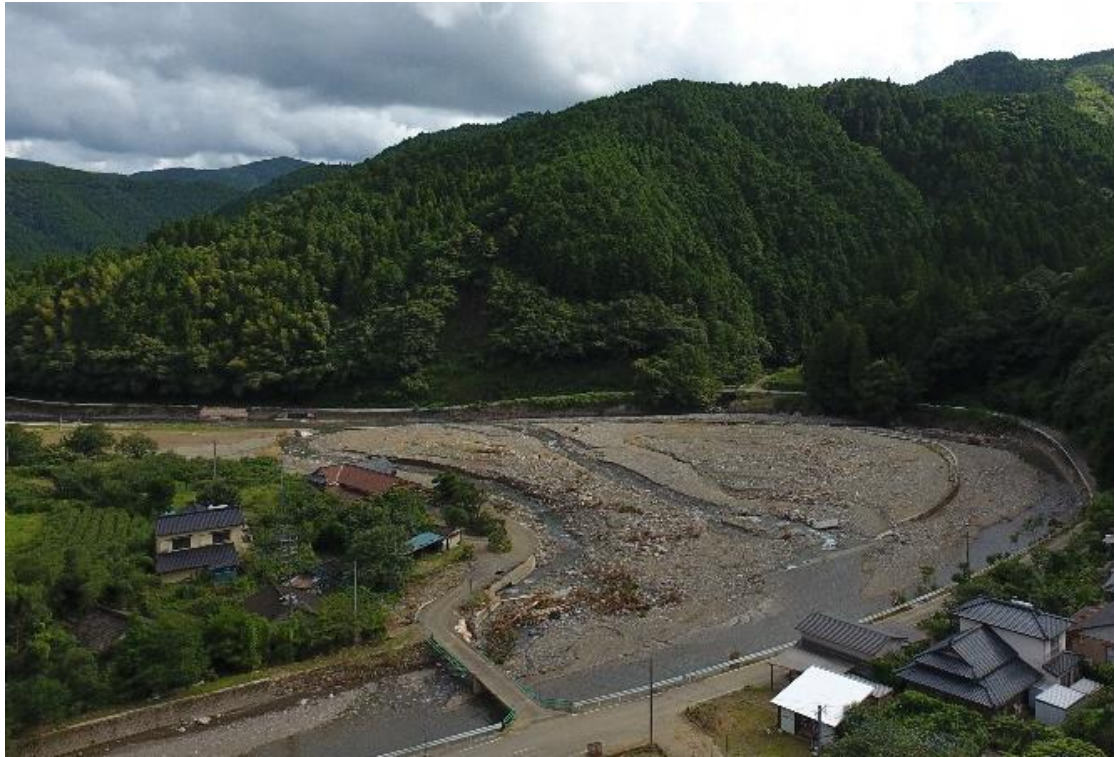
大量の土砂が流入し埋め尽くされた農地 (芦北町・大岩地区) おおいわ
