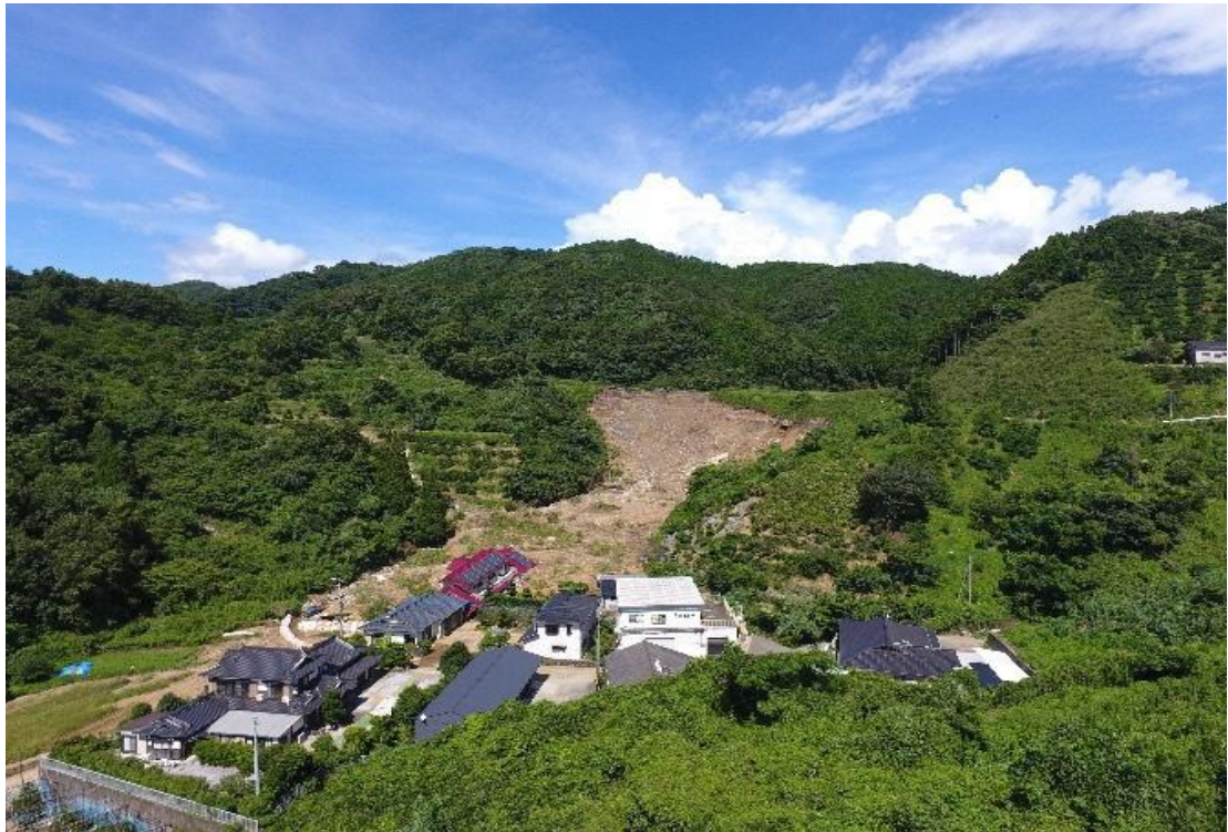
山腹崩壊 (芦北町・鶴木山地区) つるぎやま
