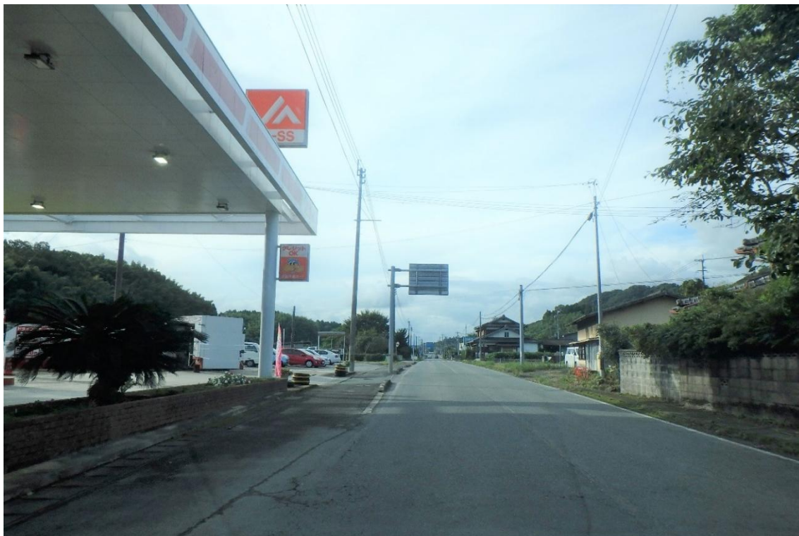
南関町小原地内:小原交差点付近(歩道設置)
