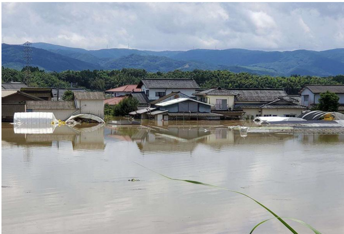
錦町一武 いちぶ （浸水状況）
