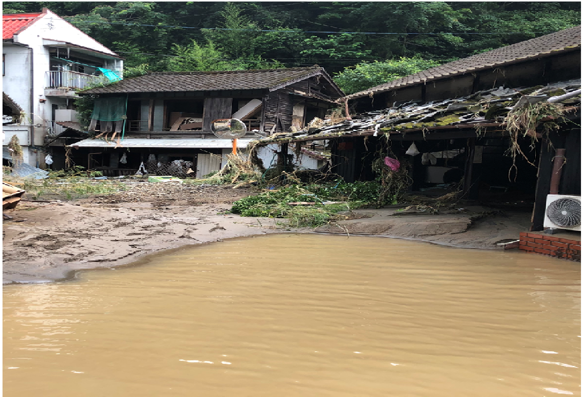
球磨村一勝地（被災状況）
