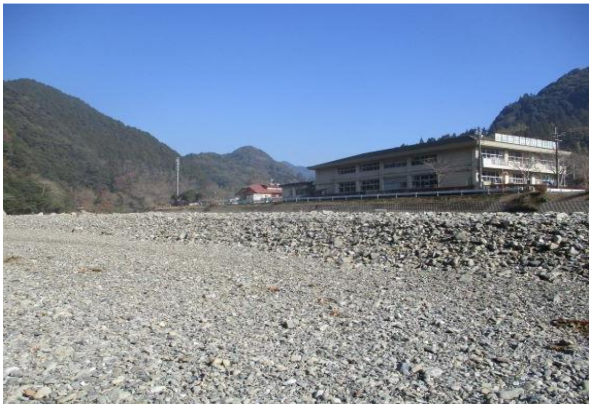
山江村 まえがわ 万江川堆積土砂（万江小学校付近）
