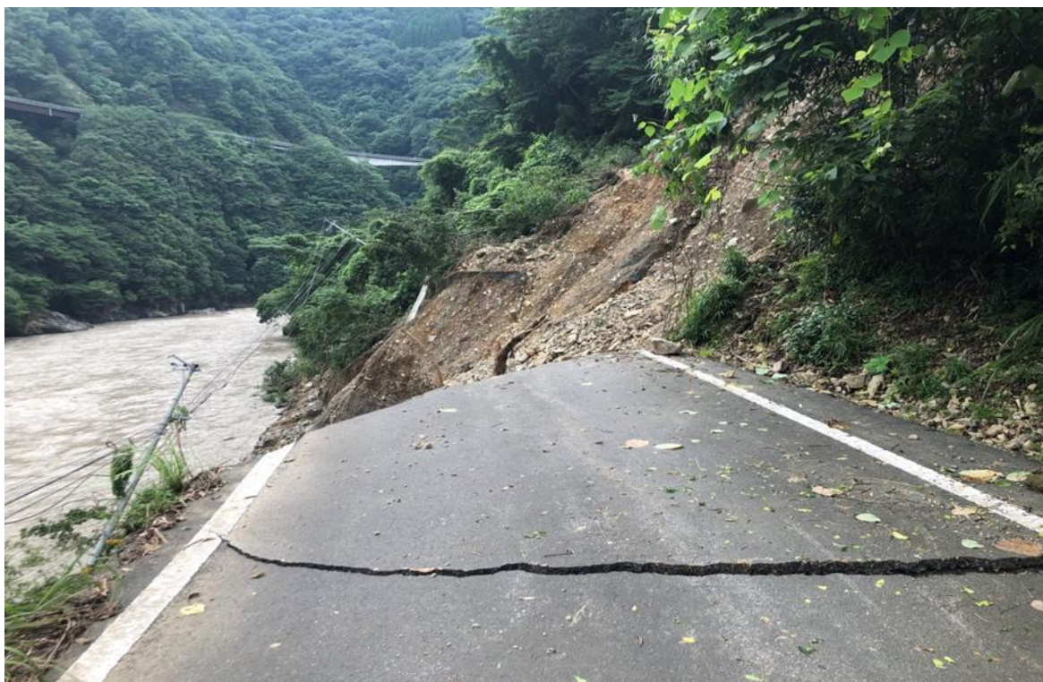
五木村村道川辺川線（被災状況）
