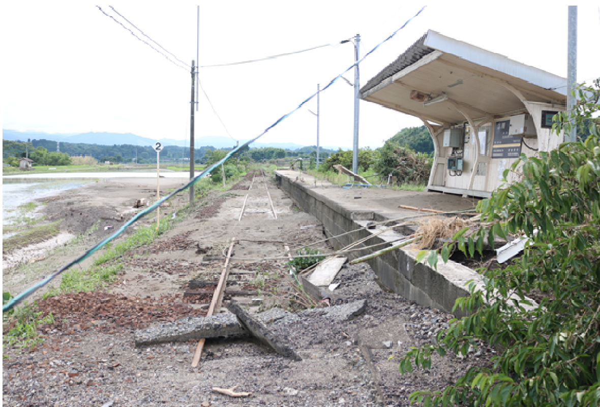
相良村川村駅（被災状況）
