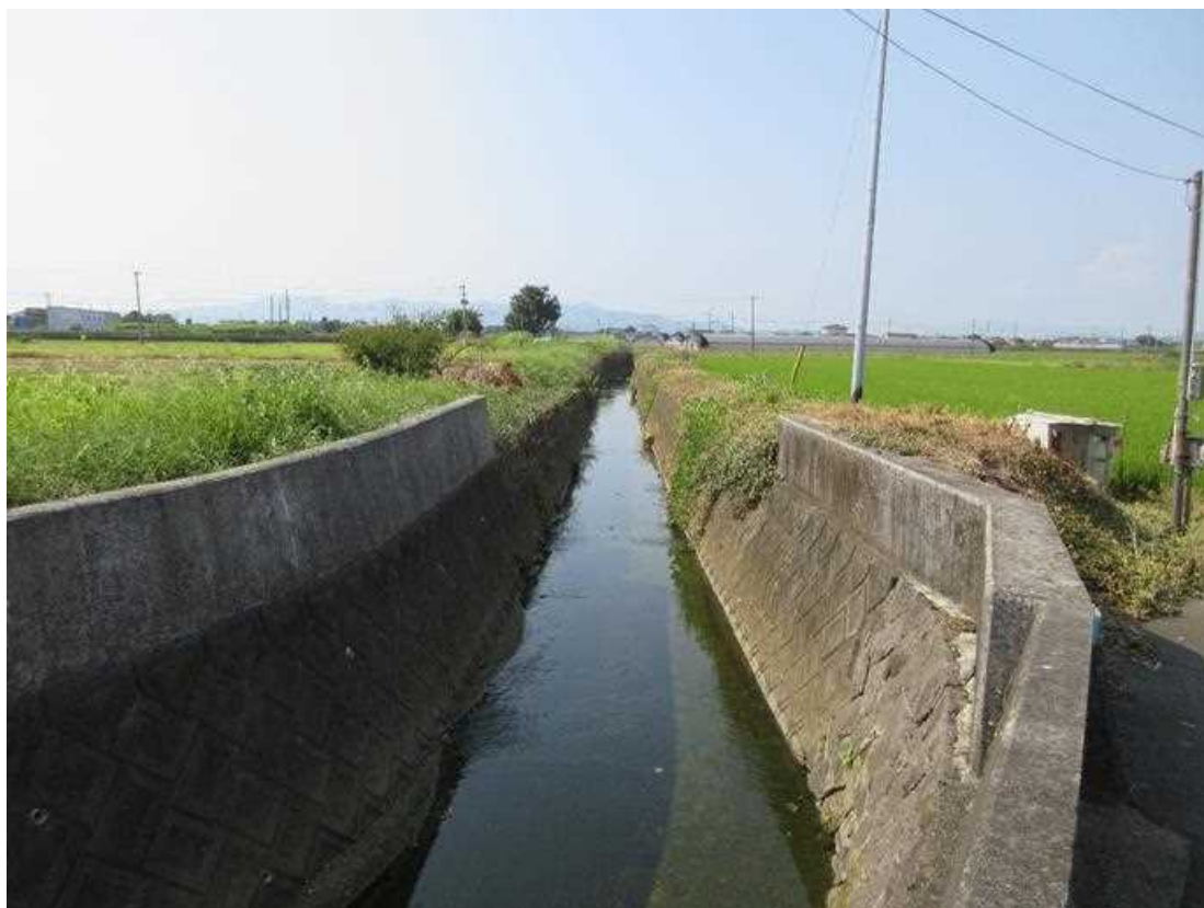
八間川護岸現況
