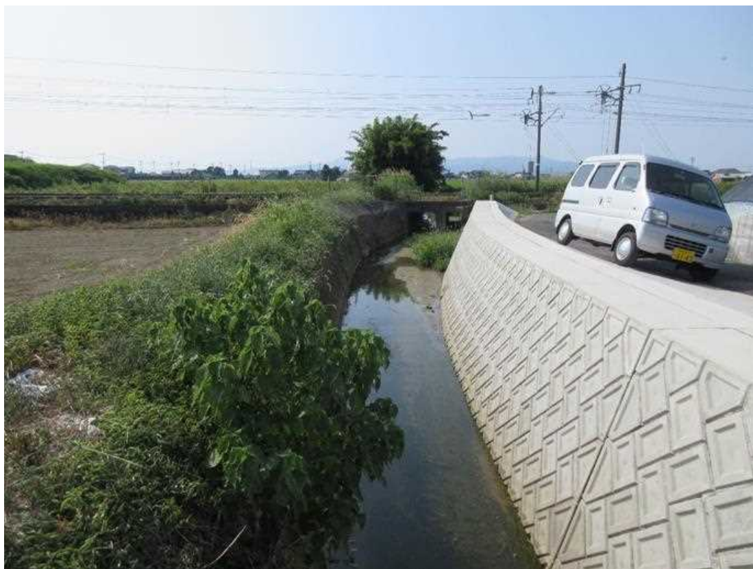
八間川護岸現況
